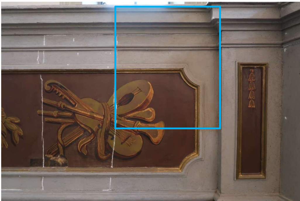
Foto 13. Durante la fase di ritocco. La ridipintura alchidica è stata rimossa ovunque per mettere in luce lo strato di chiusura grigio-azzurro. Entro il riquadro evidenziato nella foto è stata applicata la nuova patinatura che riporta le superfici verso la tonalità bruno-verdastra della policromia originaria
