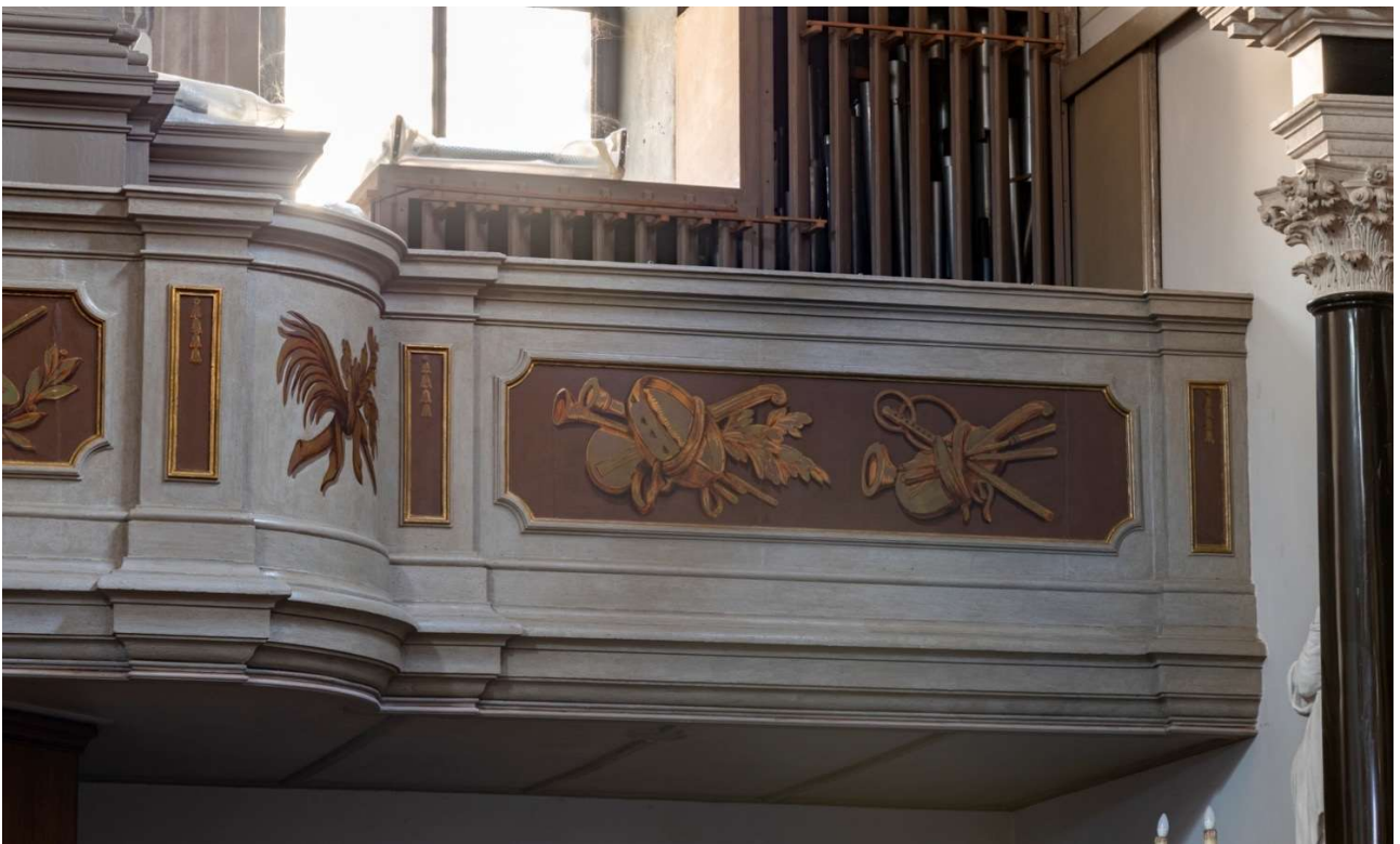
Foto 23 e 24. Particolare del palco prima e dopo l'intervento.
