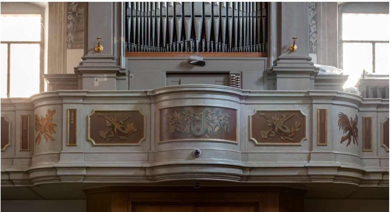
Foto 21 e 22. Il palco prima e dopo l'intervento.
