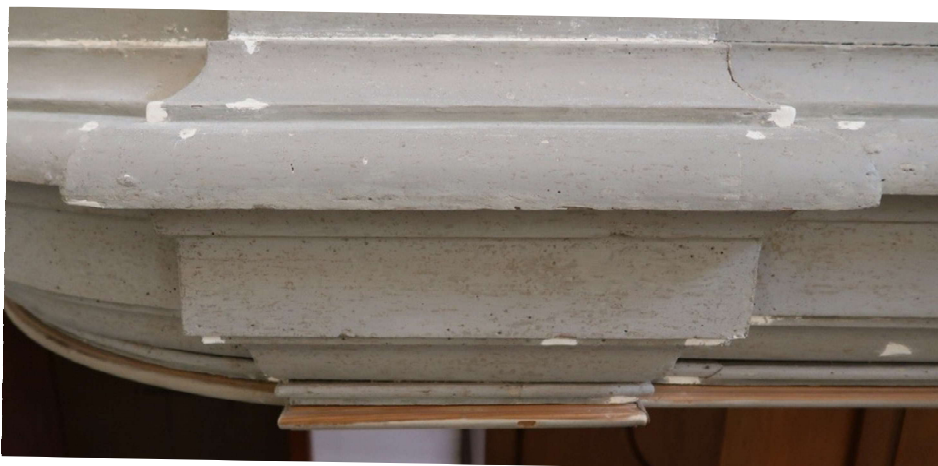
Foto 16. Le mancanze sono state integrate con pasta di legno e le lacune della policromia sono state colmate con stucco a gesso.
