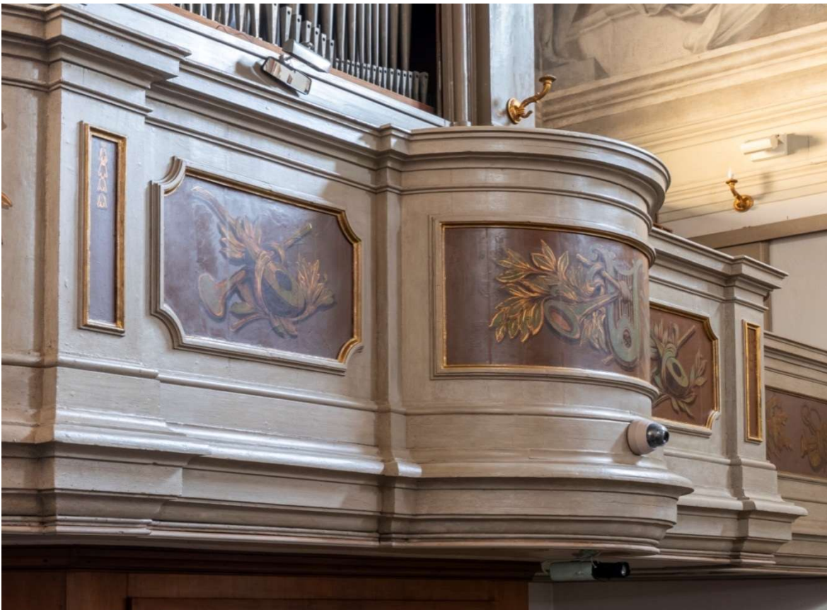
Foto 17 e 18. Durante e dopo. Le fenditure tra le tavole sono state filettate, stuccate e ritoccate.
