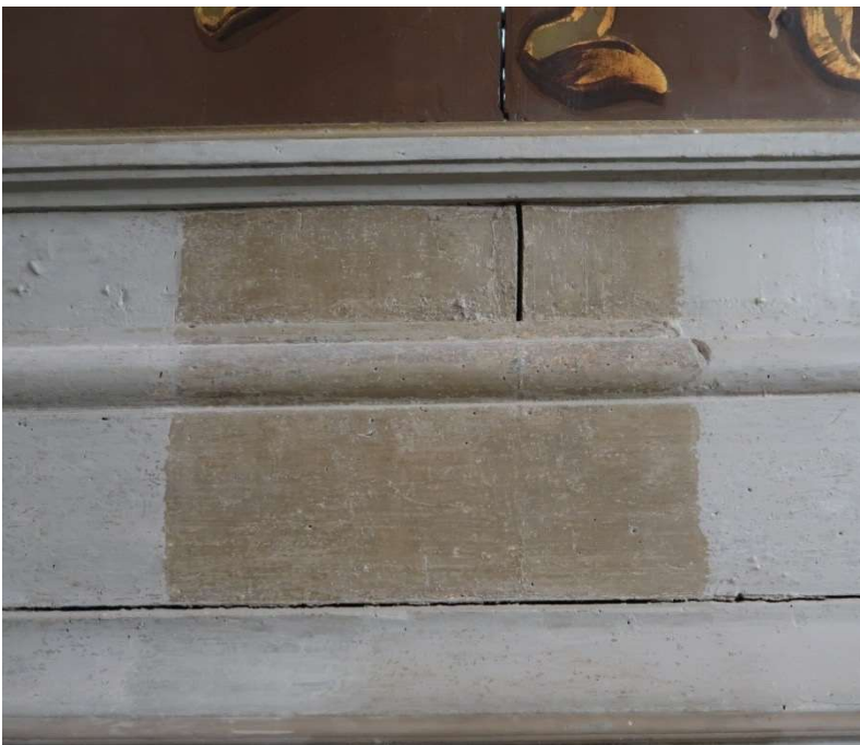
Foto 11. Durante la fase di pulitura delle superfici della struttura.
