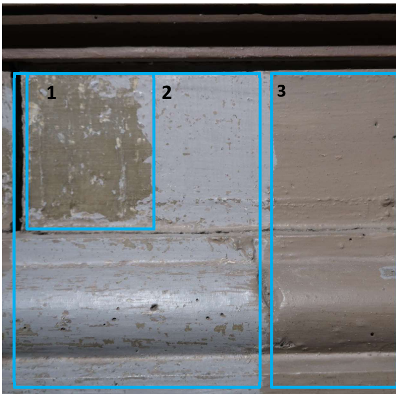
Foto 10. Sondaggio stratigrafico aperto sul lato esterno del palco sulla policromia della struttura.
