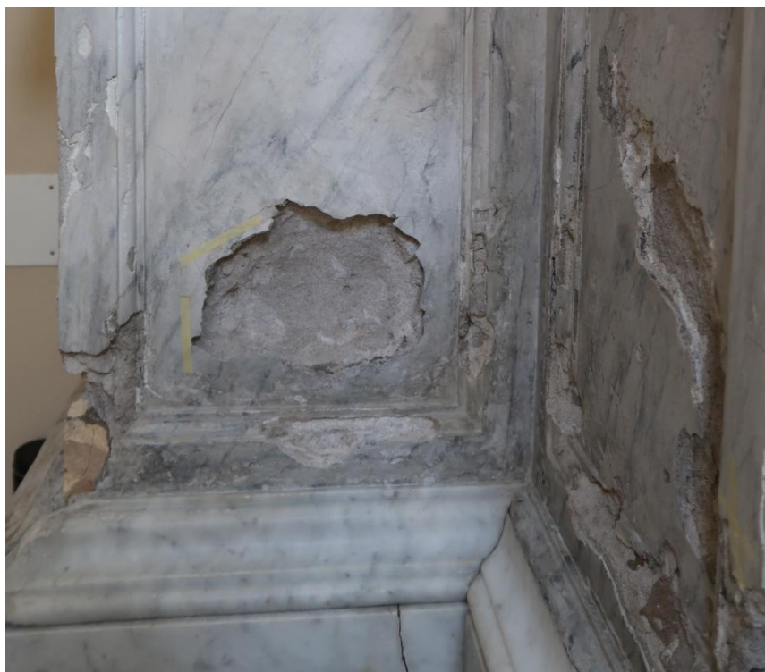
Foto 10: smontaggio delle stuccature dell'altare della Madonna
