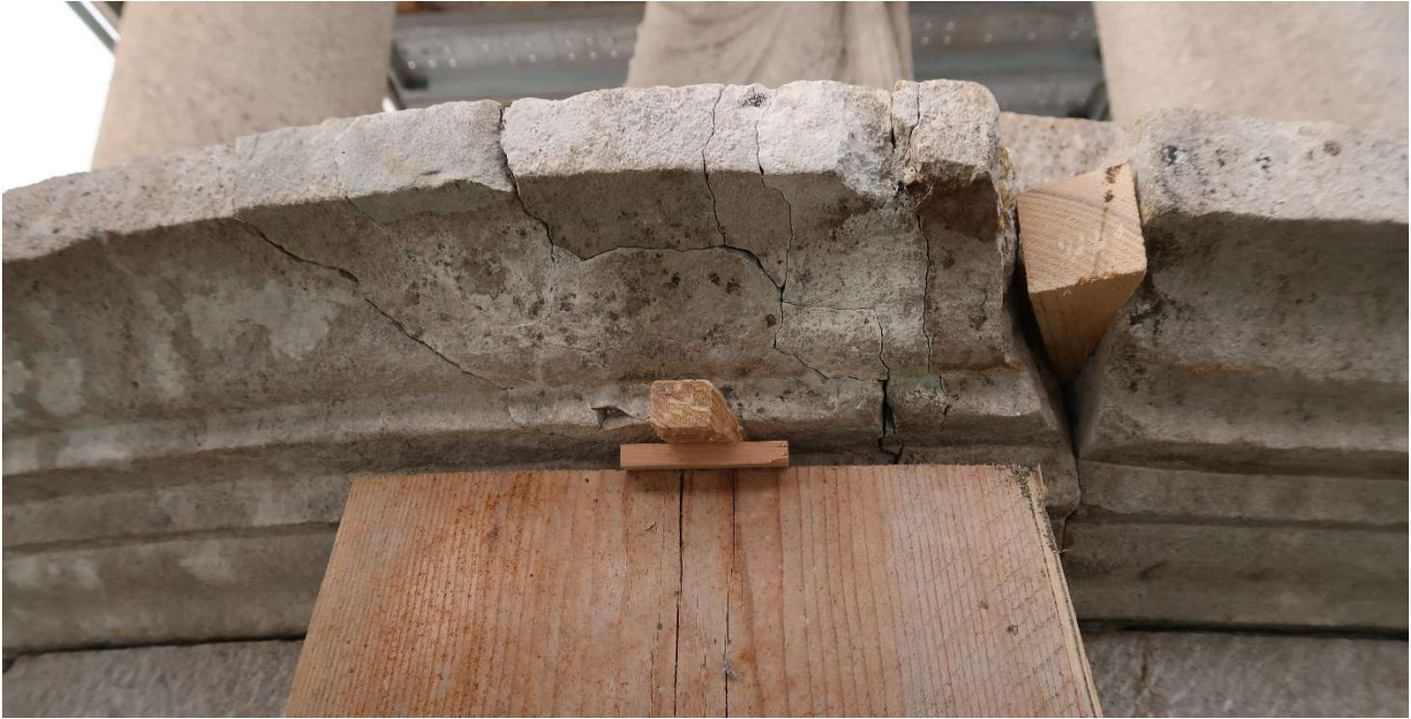
Foto 9. Particolare del cornicione del tamburo durante l'intervento: posizionamento in opera
