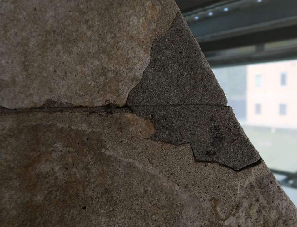
Foto 22. Particolare della cuspide piramidale durante le lavorazioni.
