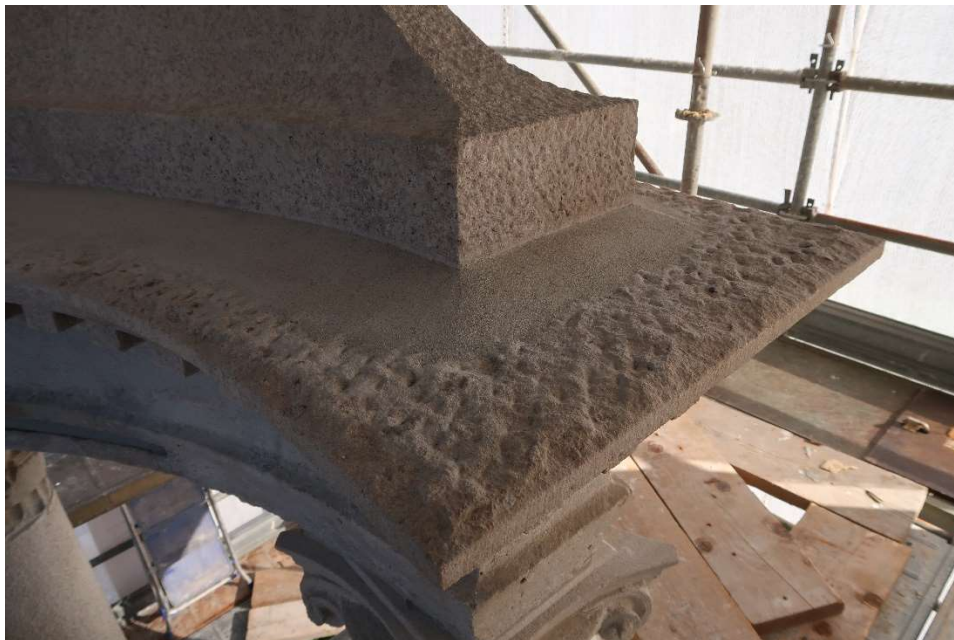
Foto 22. Particolare della cuspide piramidale dopo la realizzazione dello scivolo in malta per impedire il ristagno dell'umidità sul comicione e entro la struttura
