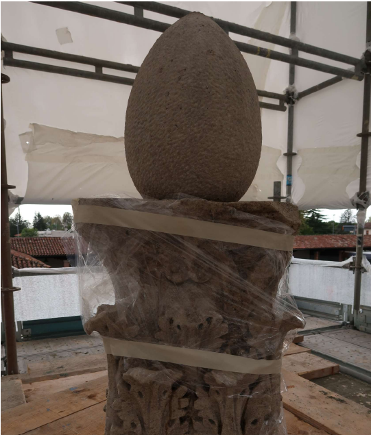
Foto 13. Particolare del capitello terminale durante l'intervento. Rifinitura della pulitura con pulitore enzimatico
