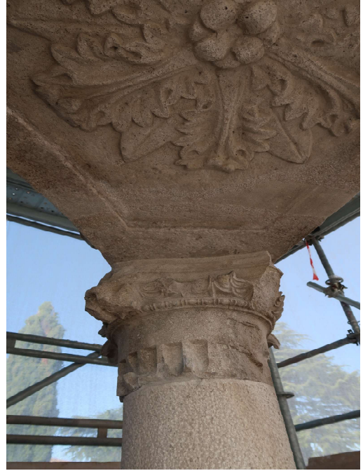
Foto 20 e 21. Particolare dell'architrave prima e dopo con: l'alleggerimento dei depositi carboniosi e la stuccatura della fessurazione
