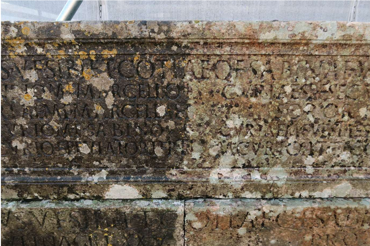
Foto 16. Particolare della balaustra durante la pulitura, dopo l'idrolavaggio
