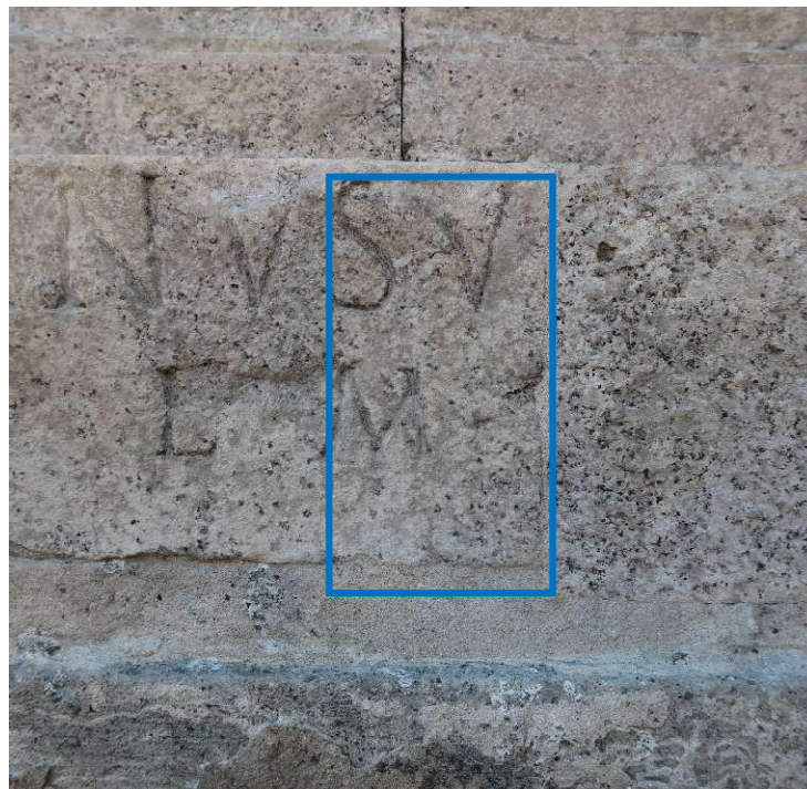
Foto 15. Particolare della balaustra in fase di rifinitura della pulitura tramite pulitore enzimatico entro il tassello centrale segnato dal riquadro blu
