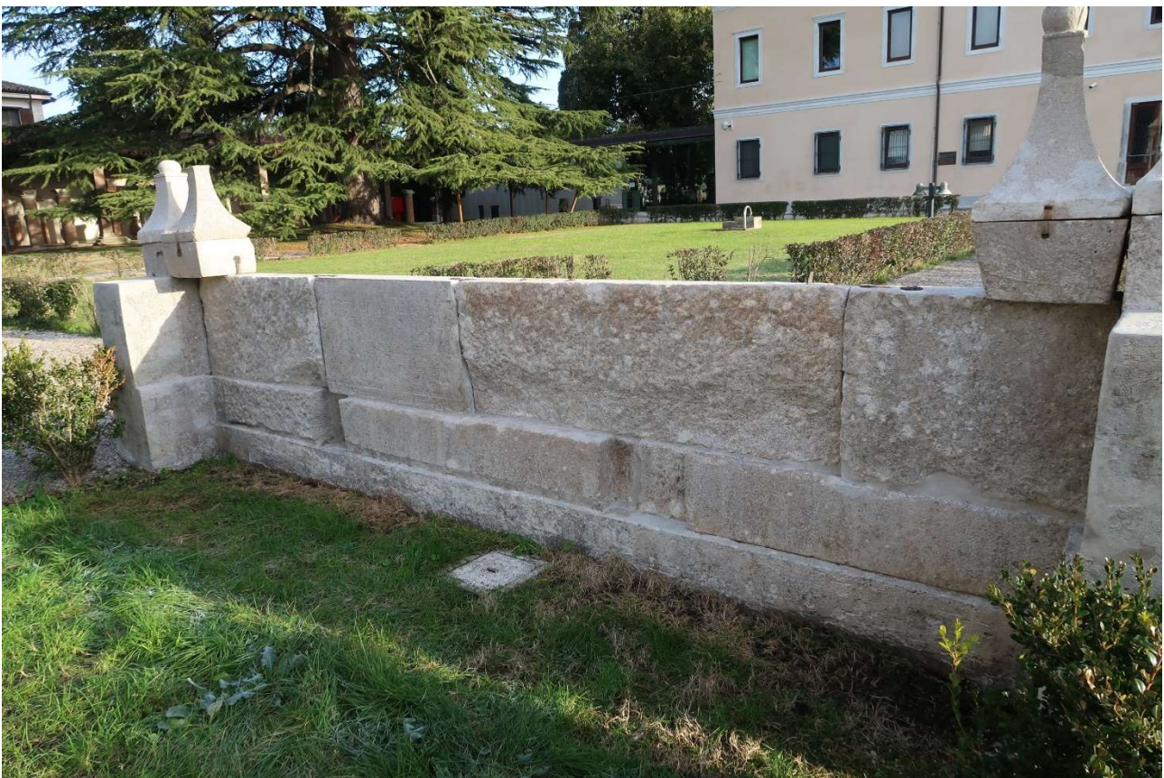
Foto 23 e 24. Particolare del retro della balaustra prima e dopo l'intervento.
