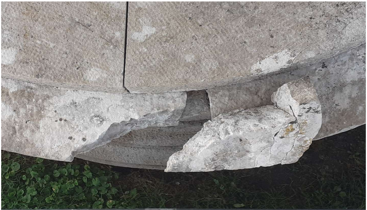
Foto 8. Particolare del cornicione del tamburo durante l'intervento: i frammenti sono stati incollati tra loro
