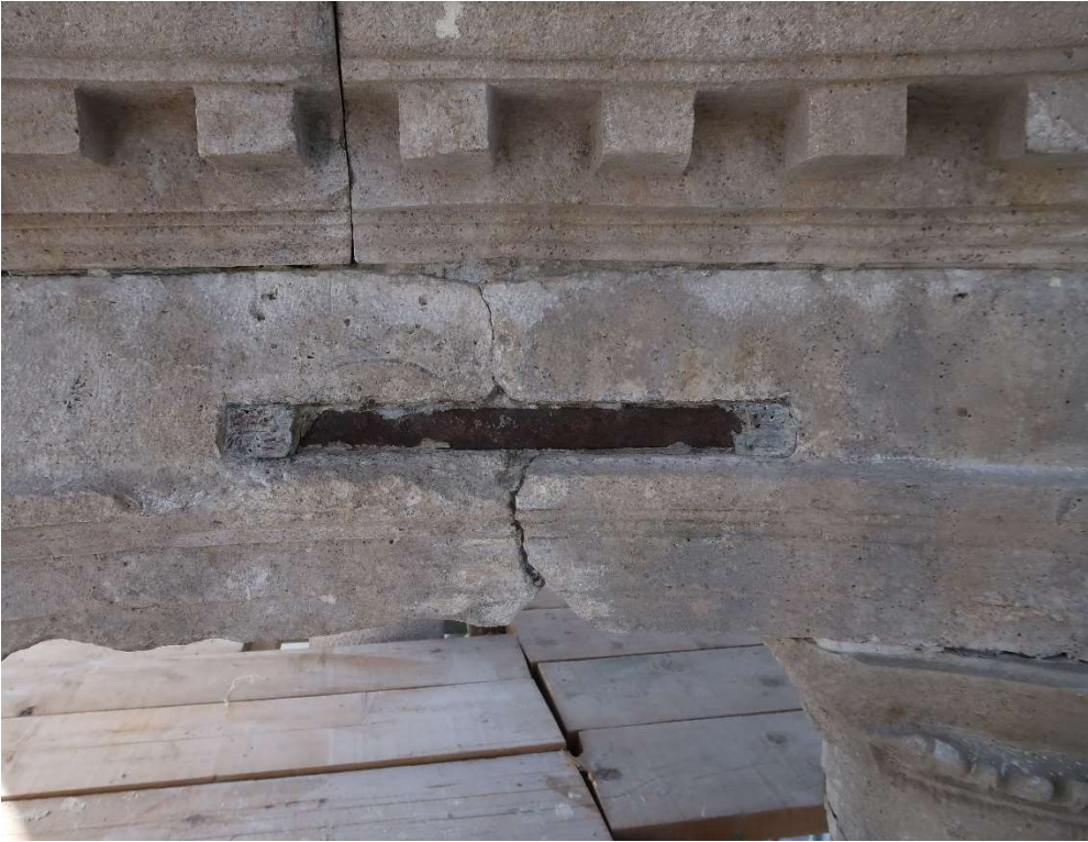
Foto 24. Particolare dell'architrave dopo la pulitura. La zanca che è stata messa in opera a consolidamento dell'architrave durante i lavori del '43-45 era ricoperta con una stuccatura ormai staccatasi.
