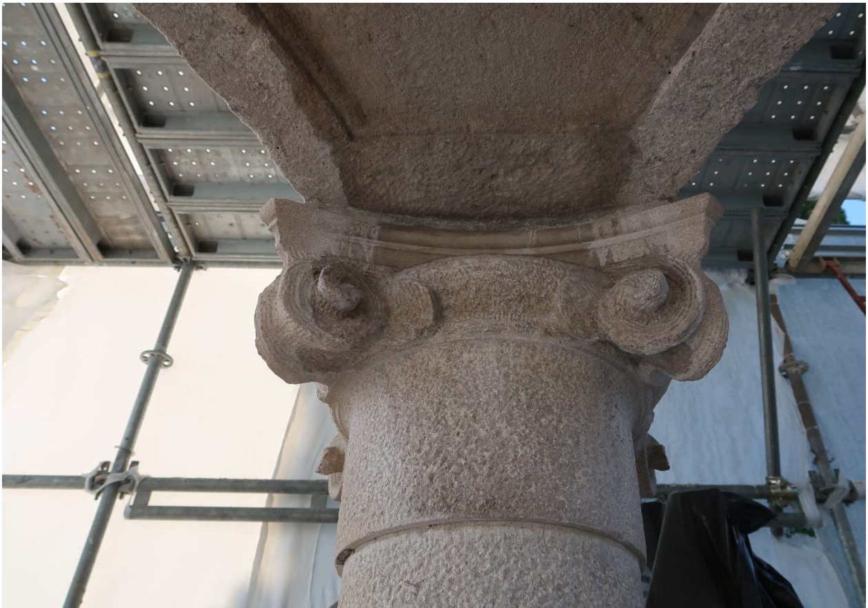
Foto 18 e 19. Particolare del capitello prima e dopo aver alleggerito i depositi carboniosi
