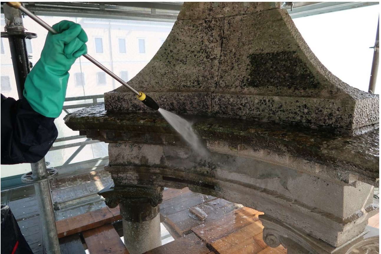
Foto 11 e 12. Particolare della cuspide piramidale durante l'intervento: fase di rimozione della placca algale mediante idrolavaggio
