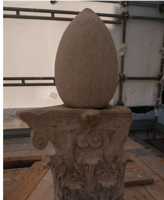
Foto 14. Particolare del capitello terminale a fine intervento
