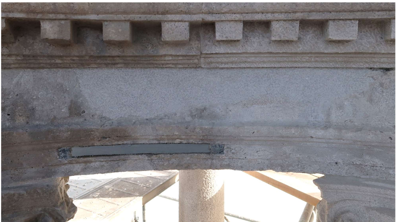
Foto 27. Particolare del lato nord dell'architrave triangolare a fine intervento
