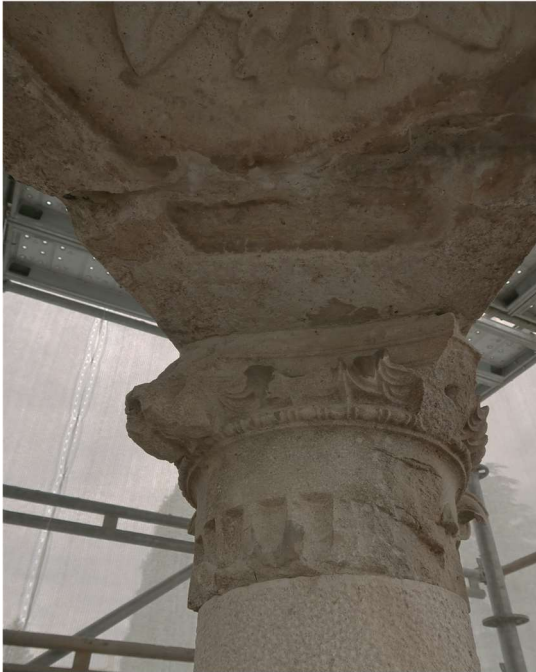
Foto 20 e 21. Particolare dell'architrave prima e dopo con: l'alleggerimento dei depositi carboniosi e la stuccatura della fessurazione
