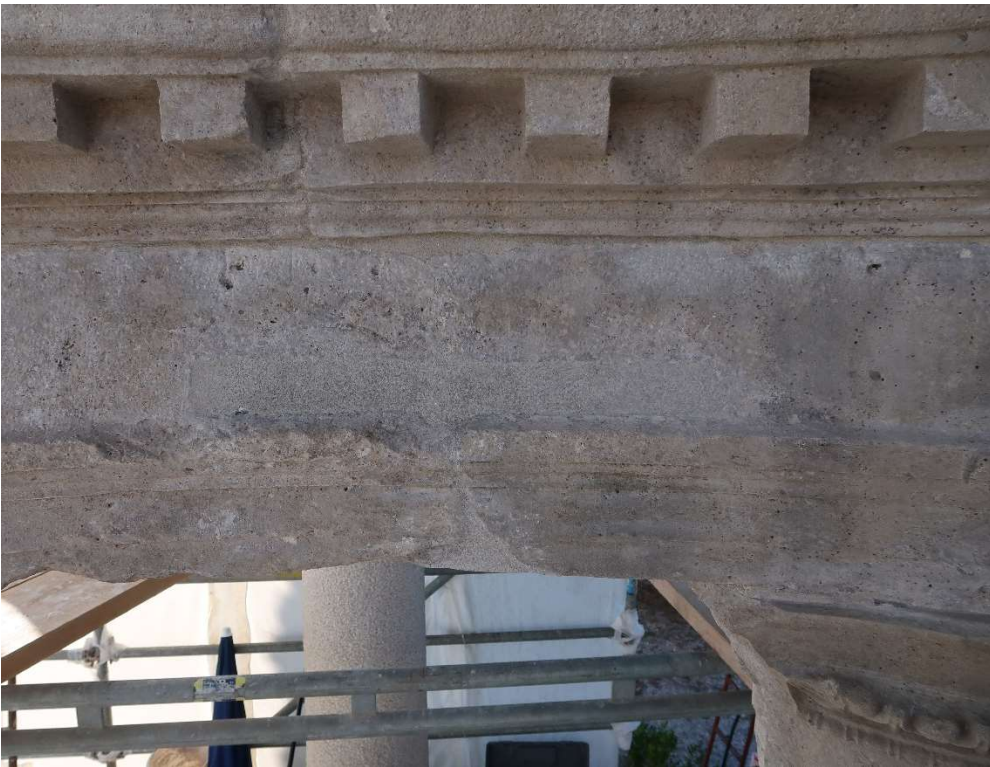
Foto 25. Lo stesso particolare dopo l'intervento di stuccatura
